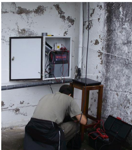
Figura 4. Instalación de antena de radio en la Torre del Aeródromo de la Isla Martín García. Gabinete con equipamiento GPS y Radio.
